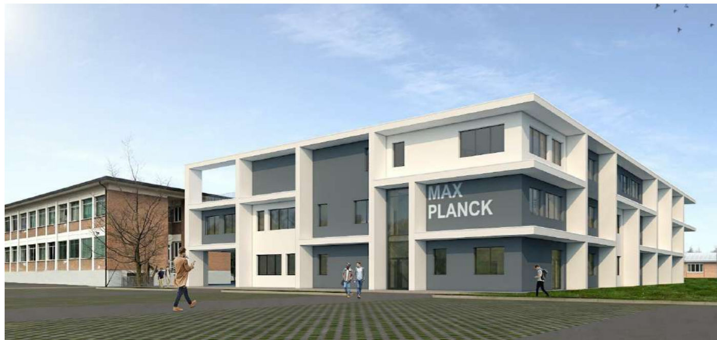
Edilizia pubblica Ristrutturazione ITIS Planck - Villorba (TV)
